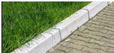
BORDURES DES TROTTOIRS
