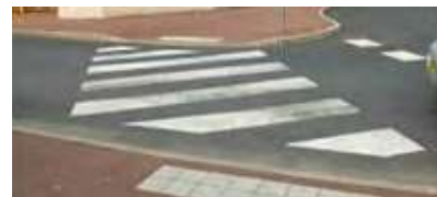
RAMPE AUX PASSAGES POUR PIÉTONS
