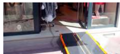
RAMPE D'ACCÈS AUX MAGASINS
