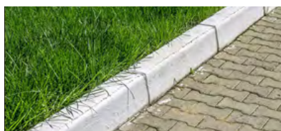
BORDURES DES TROTTOIRS
