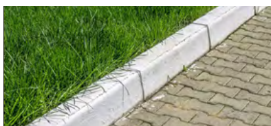
BORDURES DES TROTTOIRS
